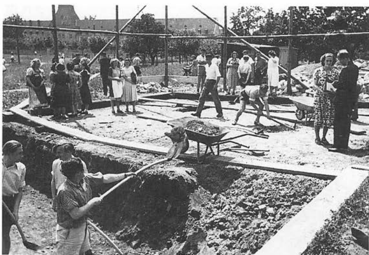
Mitwirkung vieler auf der Baustelle
